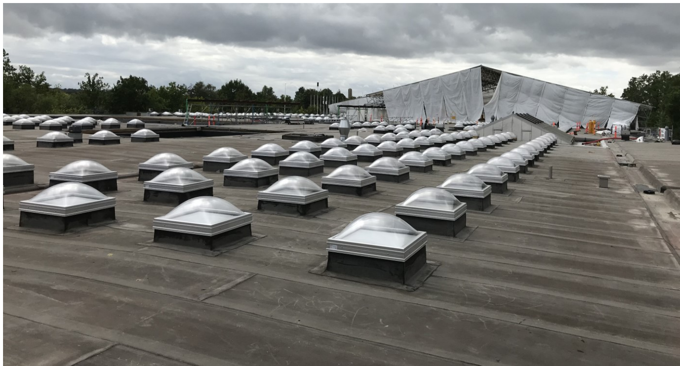
Stavnsholtsskolen fik nyt tag med tyk isolering nedenunder i 2021.
